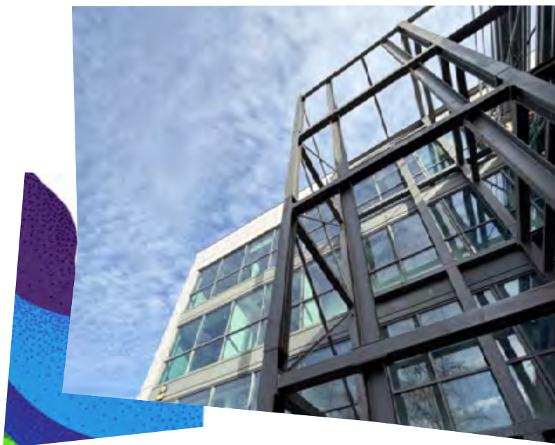
— Travaux sur la plateforme Charles-Antoine Kouakou (Paris (75)/ Saint-Ouen (93). Ouverture en mai 2026
